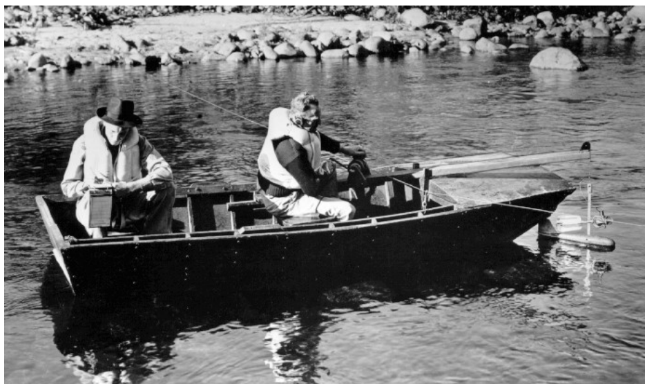
Figura N° 3.6: Medición con Molinete sobre Bote
