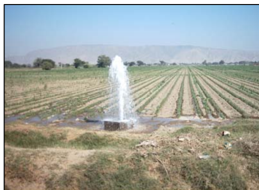
Limpieza de redes de PVC
